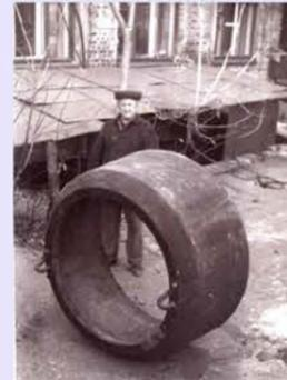
Второй пояс брони конуса конусной дробилки КВКД-1200/200 до наплавки (Сталь 35Л)
