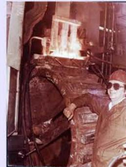
Процесс электрошлаковой наплавки износостойких слоев из высокохромистого чугуна
